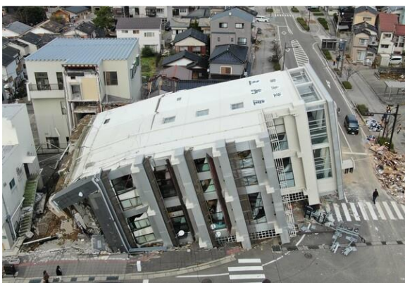
【写真】根元から横倒しになった7階建てビル：石川県輪島市 2024年1月2日(朝日新聞デジタルより)
