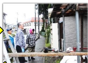
「皆で解体作業中」
