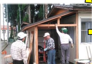
「着々と進む作業」
