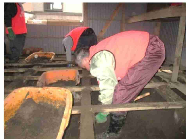
床下の泥出しの様子
