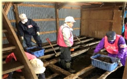
「床下の泥出しの様子」
