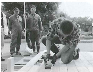
3回目：木材を再利用するための床板はがしチャレンジ
