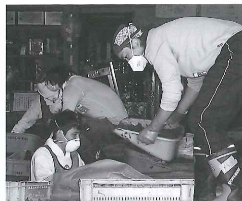
床下の泥出しをするボランティア
