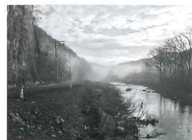
崩落した道路
